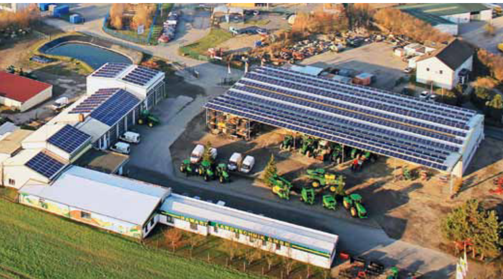
Baumärkte müssen nur ihre Dachfläche zur Verfügung stellen. Das schont die Umwelt und verringert die Betriebskosten.
