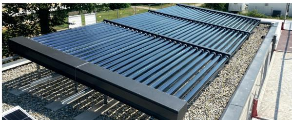
Die benötigte Prozesswärme wird mittels innovativer Vakuumröhren-Solarluftkollektoren bereitgestellt.
